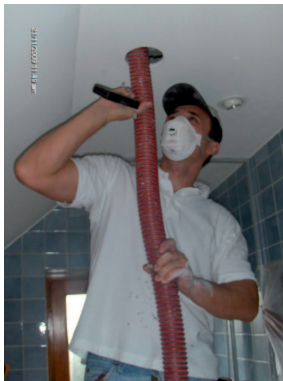
celulosa isofloc insuflada en falsos techos de cartón yeso
