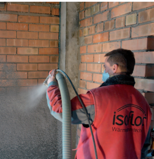
celulosa isofloc proyectada sobre pared y muros
