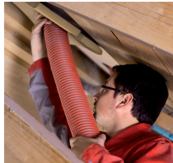
celulosa isofloc insuflada en cubiertas de madera
